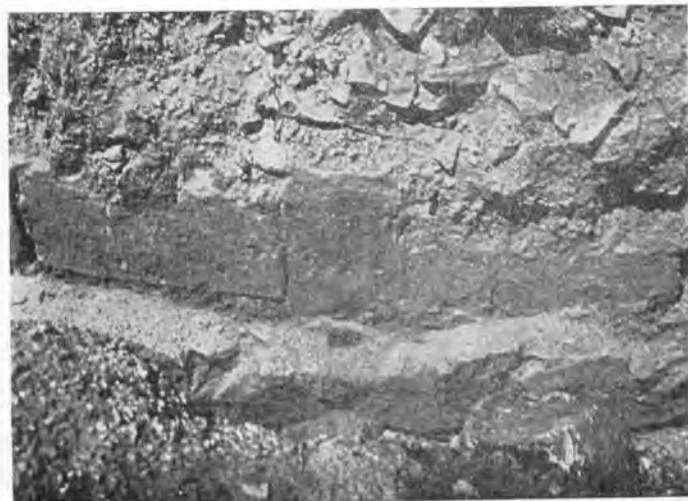
Сл. 10. Апсида са оловом у вертикалним спојницама — Fig. 10. Mur de l'abside avec du plomb dans les jointures verticales
