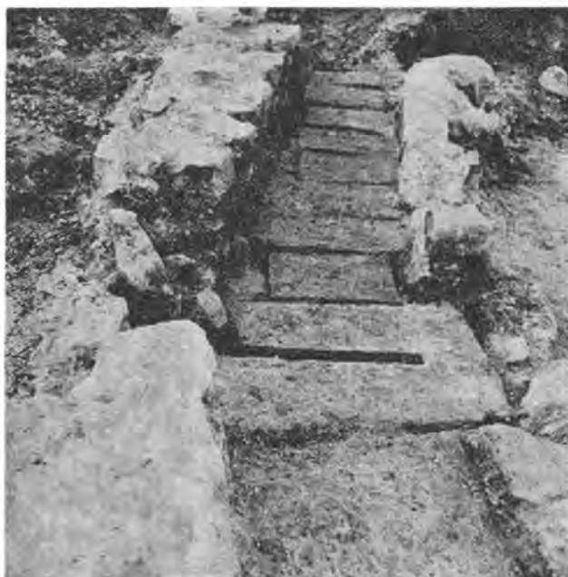
Сл. 19. — Доводни канал С; детаљ каменог блока са уклесаним лежиштем за уставу I, поглед са истока. — Fig. 19. — La conduit C; le détail du bloc de pierre avec le siège taillé de vanne I, vue d'est.
