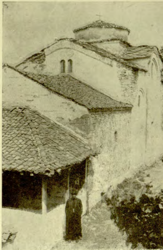
Сл. 5. Црква у Кончи. Изглед са југоистока Fig. 5. Eglise de Konča. Vue de sud-est
