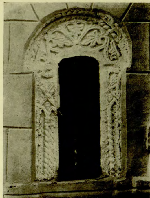
Сл. 62. Велуће, западни прозор на северној фасади Fig. 62. Veliče, fenêtre ouest de la façade septentrionale
