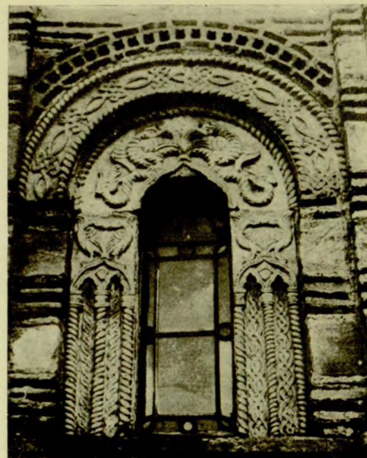
Сл. 74. Лазарица, источни прозор на јужној фасади; сравни са сл. 56, 60, 62 Fig. 74. Lazarica, fenêtre est de la façade méridionale, comparer avec les fig. 54, 58, 60
