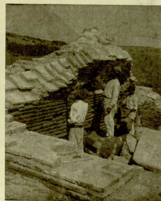
Сл. 20. Остатак свода централног брода после конзервације Fig. 20. Reste de la voûte de la nef centrale après les travaux de conservation
