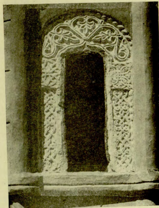
Сл. 57. Велуће, прозор на јужној апсиди Fig. 57. Veluča, fenêtre de l'abside méridionale
