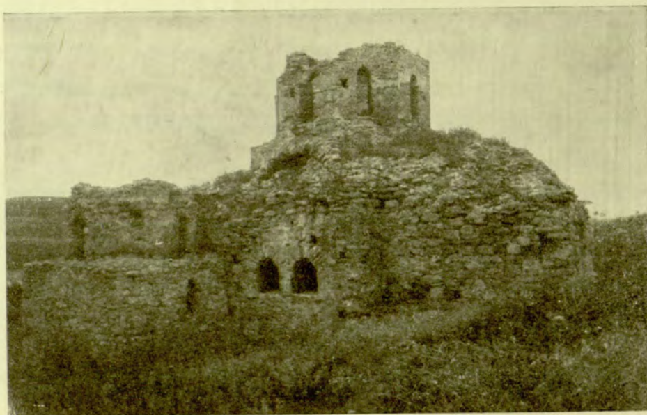
Сл. 14. Развалине манастира Св. Ђорђа у Гор. Козјаку. Изглед са југоистока Fig. 14. Ruines du monastère de St Georges à Gornji Kozjak. Vue du sud-est
