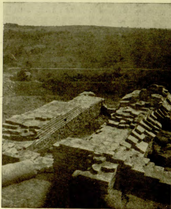
Сл. 16. Северни брод крипте после конзервације Fig. 16. Nef septentrionale de la crypte après les travaux de conservation
