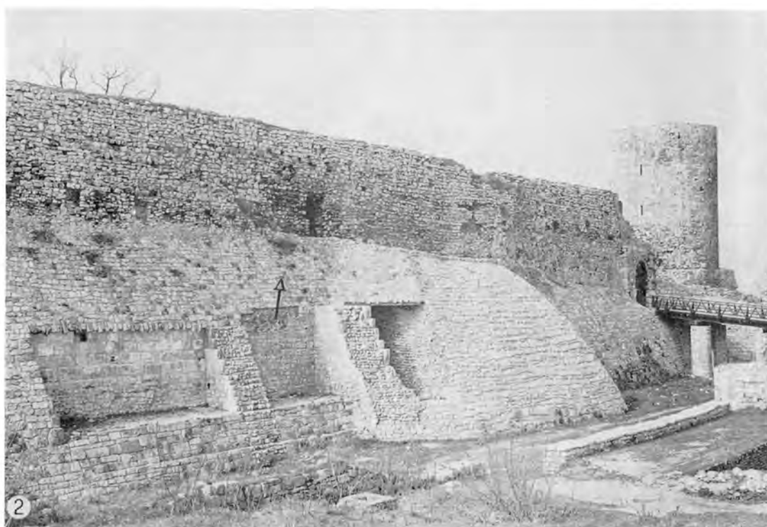
Т. I, Сл. 1. — Римска кула у ескарпи северо-источног средњовековног бедема на Горњем граду. Сл. 2. — Конзервирани део северо-источног бедема и куле римског логора на Горњем граду.
